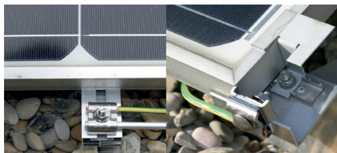
Rys. 27. Przykład zastosowania zacisku uziemiającego UNI; dzięki elementowi pośredniemu ze stali nierdzewnej zacisk pozwala uniknąć korozji, tworząc niezawodne wieloletnie połączenie między różnymi materiałami przewodzącymi
